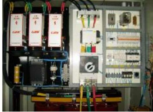
图 2-5 高频振荡器可控硅交流调压系统
